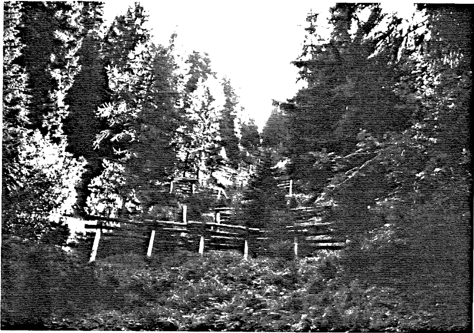
Bild 2 : Blick von der Waldstrasse in die Lawinenschneise oberhalb des Uebungsobj. Nr. 2. Auf dieser Aufnahme sind die teilweise zerstörten Verbauungen und das Windfenster am Anfang des Lawinenzuges gut sichtbar.
